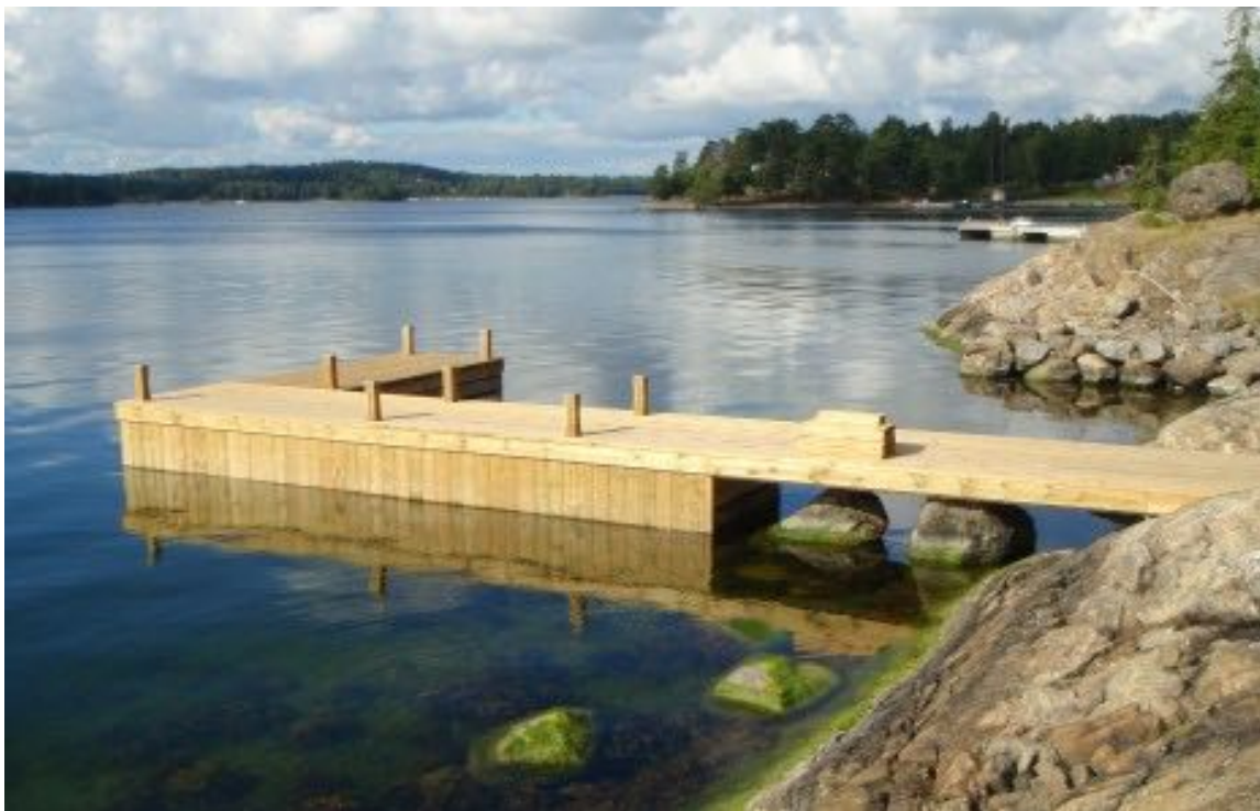
Denna brygga som byggts som en tät och vågbrytande brygga på dess yttre del, har en "vattenöppning" längst in närmast stranden för att därigenom öka vattengenomströmningen.
